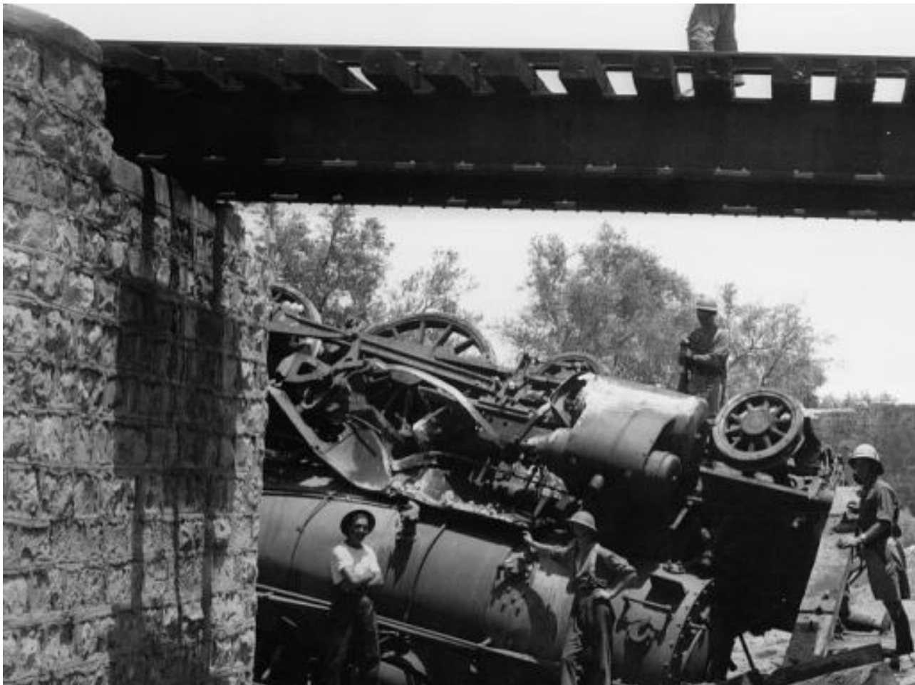
Locomotiva a vapore Baldwin delle Ferrovie della Palestina, fatta deragliare dai palestinesi che opponevano resistenza ai processi di colonizzazione britannica durante la Grande Rivolta, 2 gennaio 1936 (American Colony Photo Department)
